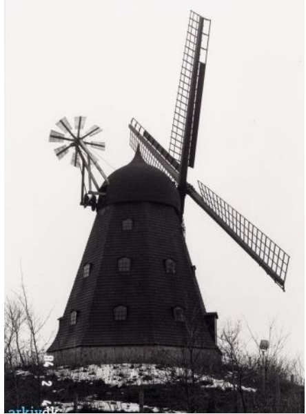
Den nye mølle fra Stødov blev opført og indviet 1. november 1974
